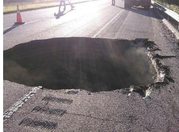
12.10. В американском штате Вирджиния (округ Саутгемптон) на одной из дорог образовался провал грунта 5х6м.
